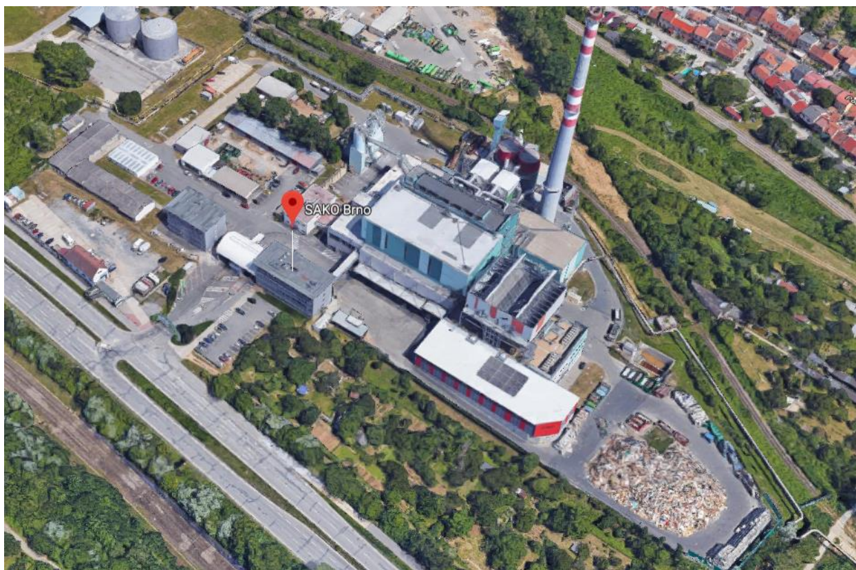
Obrázek 50: Letecký pohled na spalovnu SAKO Brno, a.s.
