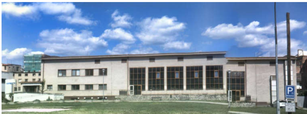
Krytý plavecký bazén Ponávka (stav před rekonstrukcí)
