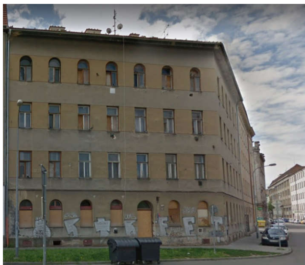
Bytový dům Podnásepní 2 (stav před rekonstrukcí)
