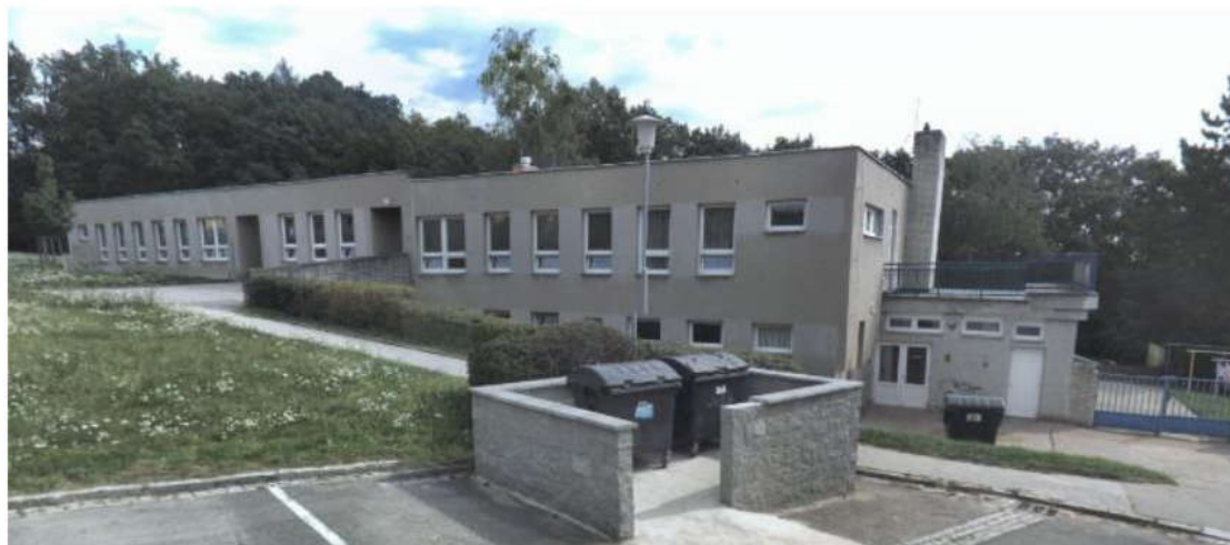
Objekt Stamicova, jesle (stav před rekonstrukcí)
