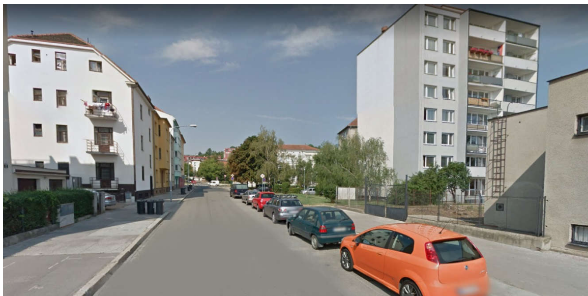
Bytové domy Vojtova (stav po rekonstrukci)
