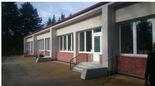
MŠ Nejedlého (po rekonstrukci)
