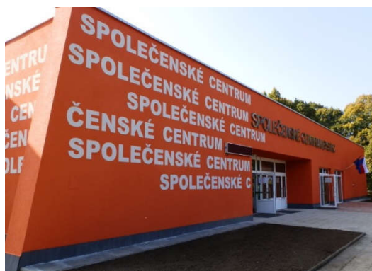
Společenské centrum Brno - Bystrc (stav po rekonstrukci)
