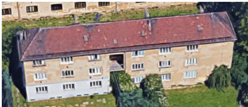
Bytový dům Gallašova 51/8 (stav před rekonstrukcí)
