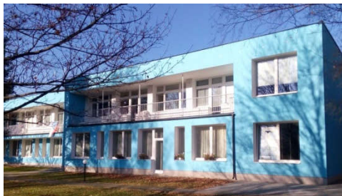
Radnice Oderská 4 (po rekonstrukci)
