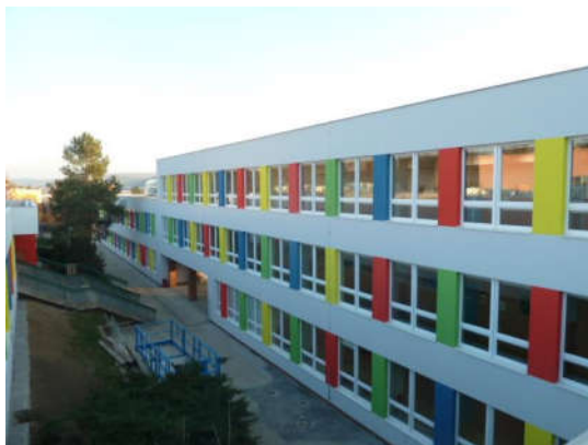
ZŠ Laštůvkova (stav po rekonstrukci)
