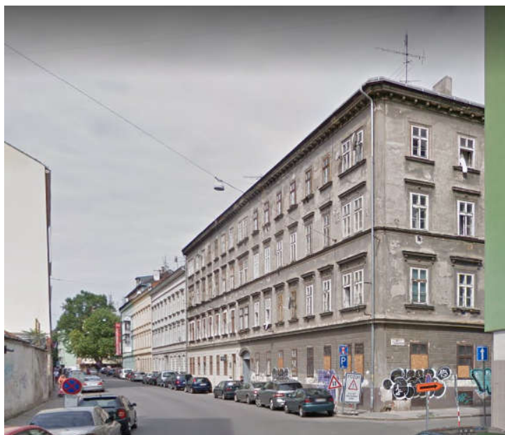
Bytový dům Bratislavská 265/71 (stav před rekonstrukcí)
