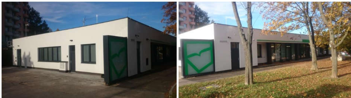
Rekonstrukce KJM na ulici Vondrákova (po rekonstrukci)
