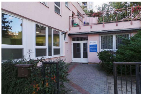
Rekonstrukce domu pro seniory Hapalova 20 (před rekonstrukcí)
