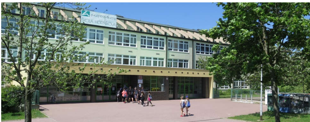
ZŠ a MŠ Horníkova (stav před rekonstrukcí)
