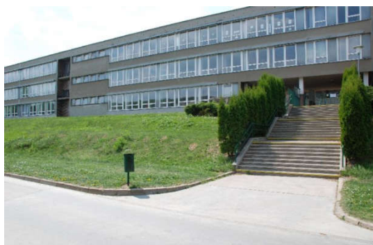
ZŠ Laštůvkova (stav před rekonstrukcí)
