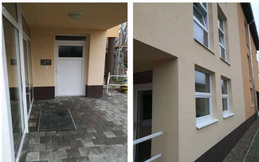
Bytový dům Konopiska (stav po rekonstrukci)
