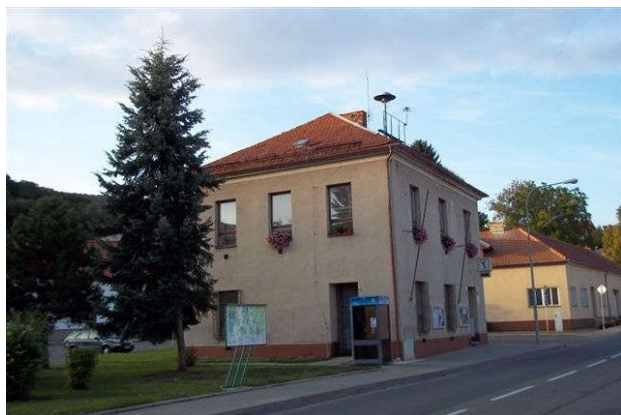
ÚMČ Brno - Ivanovice (stav před rekonstrukcí)
