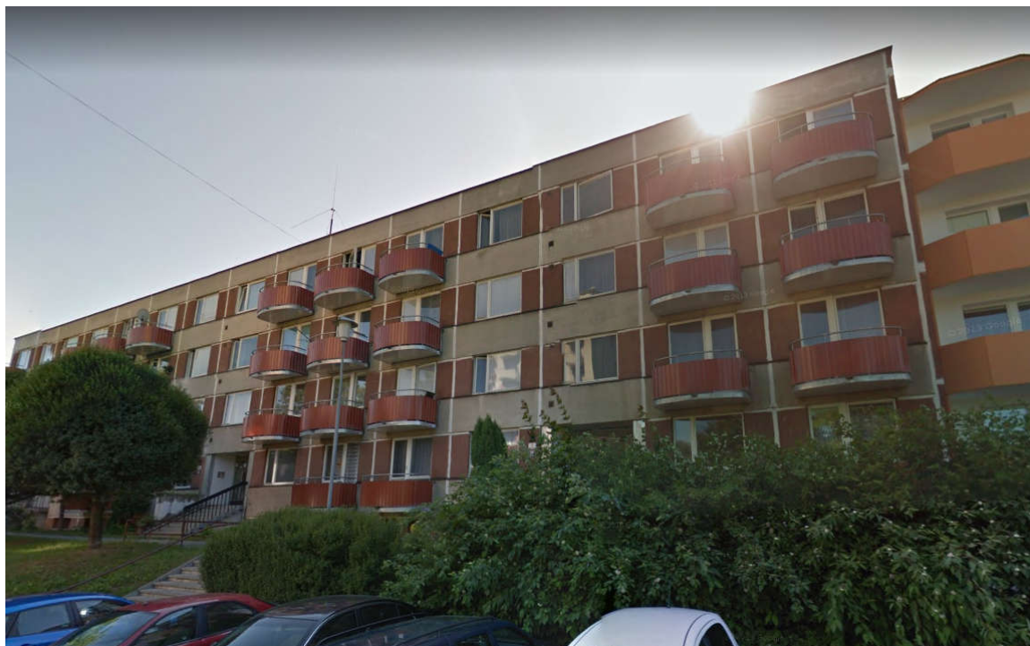
Bytový dům Píškova 8,10,12 (stav před rekonstrukcí)
