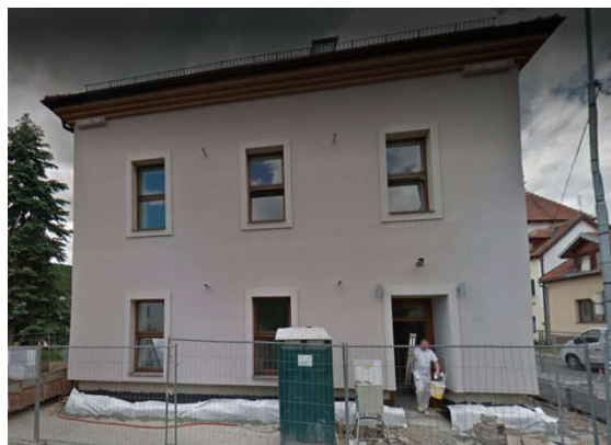
ÚMČ Brno - Ivanovice (stav po rekonstrukci)
