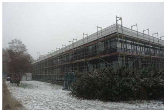
Poliklinika Lesná (v průběhu rekonstrukce)
