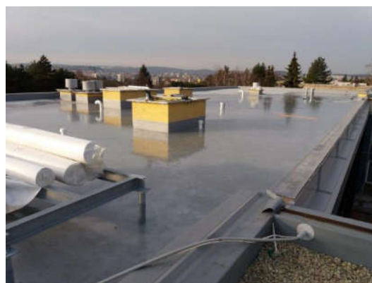
Poliklinika Lesná (v průběhu rekonstrukce)
