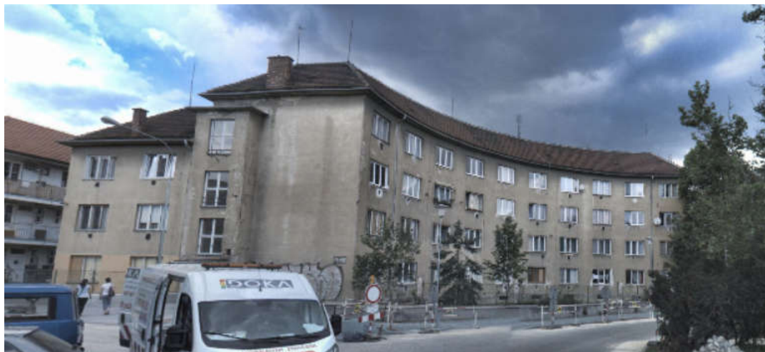
Bytový dům Gallašova 782/2 (stav před rekonstrukcí)
