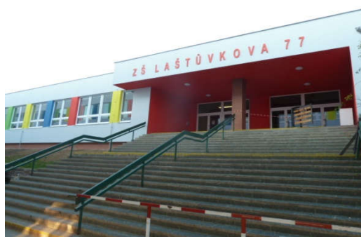
ZŠ Laštůvkova (stav po rekonstrukci)
