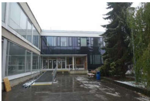
Poliklinika Lesná (v průběhu rekonstrukce)
