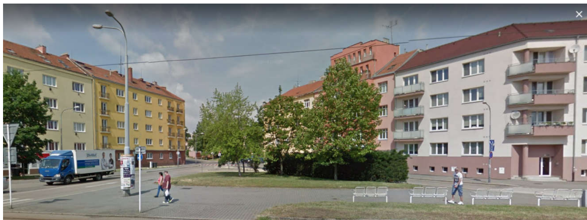
Bytové domy Vojtova (stav po rekonstrukci)
