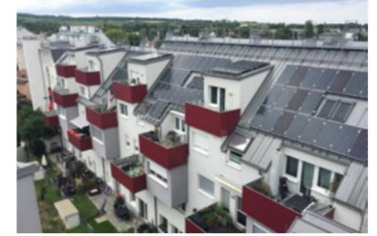
PV auf Mehrparteiengebäude
