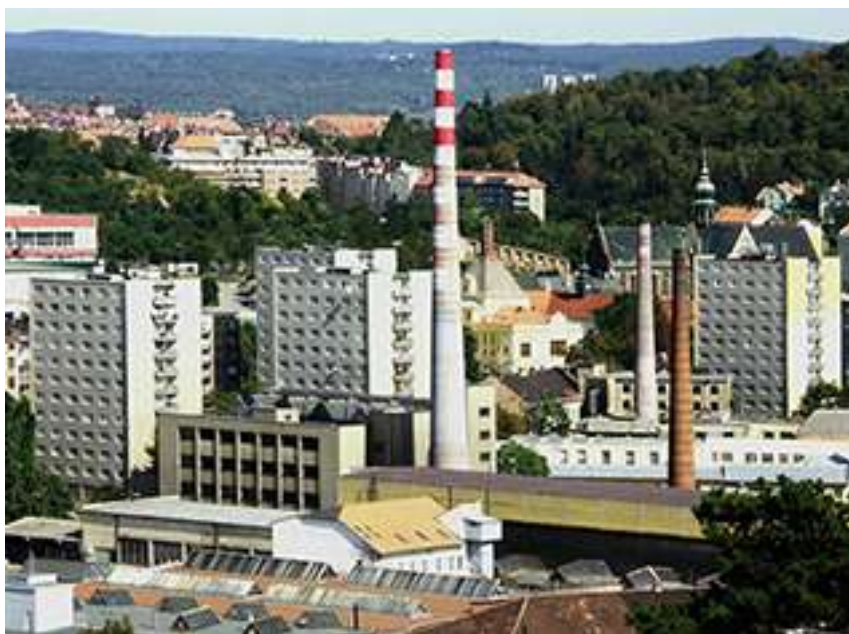
Obrázek 12: Pohled na objekty Provozu Staré Brno
