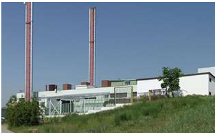
Obrázek 15: Pohled na objekt BIO kotelny Teyschlova
