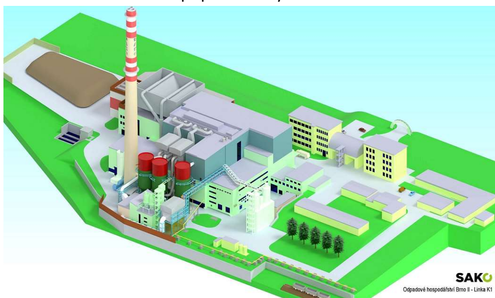
Obrázek 4: Vizualizace ZEVO po zprovoznění linky s třetím kotlem K1
