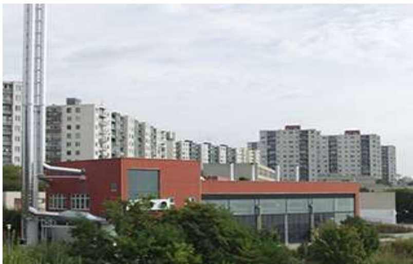
Obrázek 14: Pohled na objekt typické plynové kotelny
