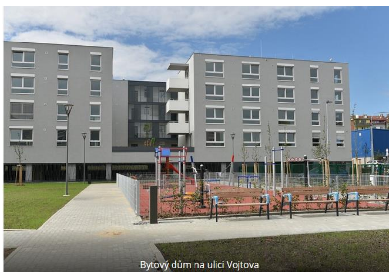
Obrázek 9: Bytové domy Vojtova
