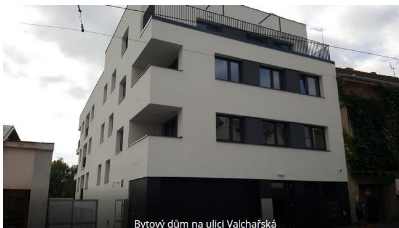
Obrázek 8: Bytový dům Valchařská
