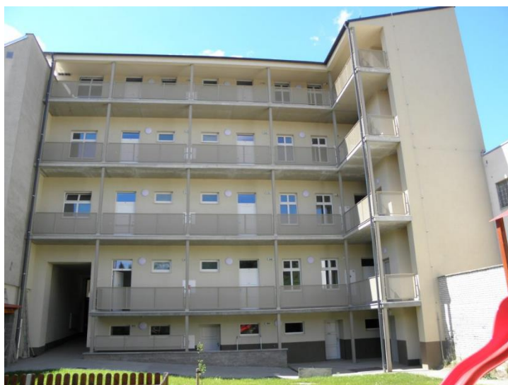
Obrázek 22: Bytový dům Hálkova 4
