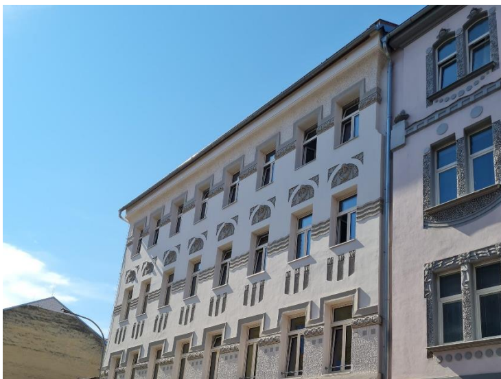
Obrázek 18: Bytový dům Vlhká 22
